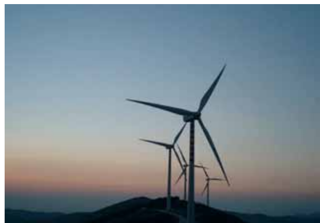
Windkraftanlagen Wind power
